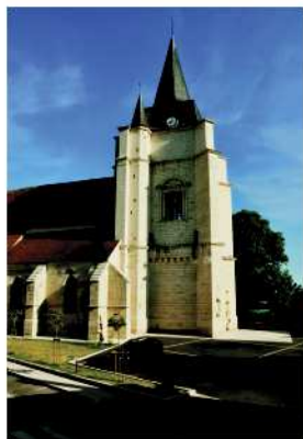
1 Église côté rue
