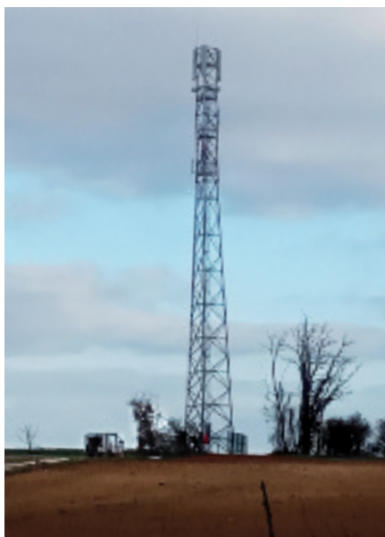
Pylône de l'antenne Orange. : ©Mairie de Suilly.
